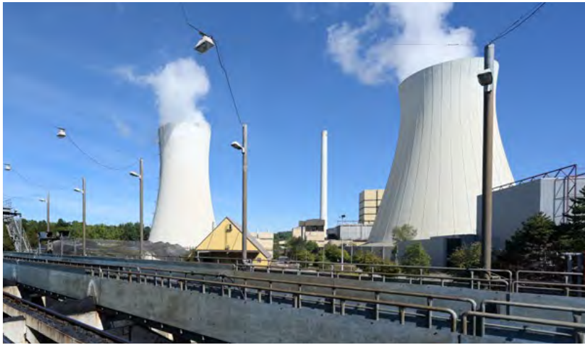
Das Steag-Kraftwerk Fenne in Völklingen.
