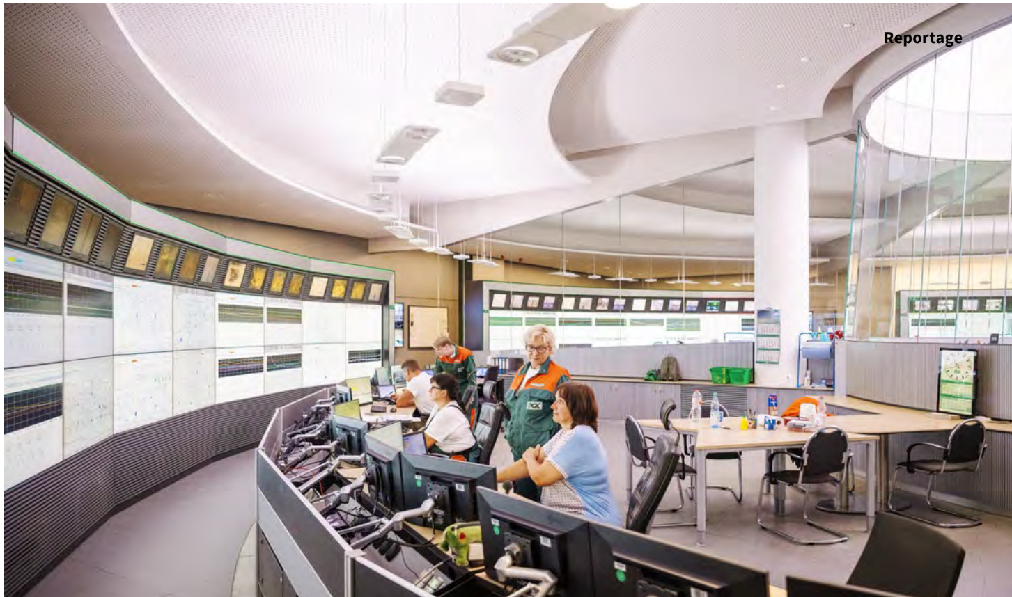
Die zentrale Messwarte ist das Herzstück von PCK. Hier werden Temperatur, Druck und Füllstände der Anlagen überwacht.
